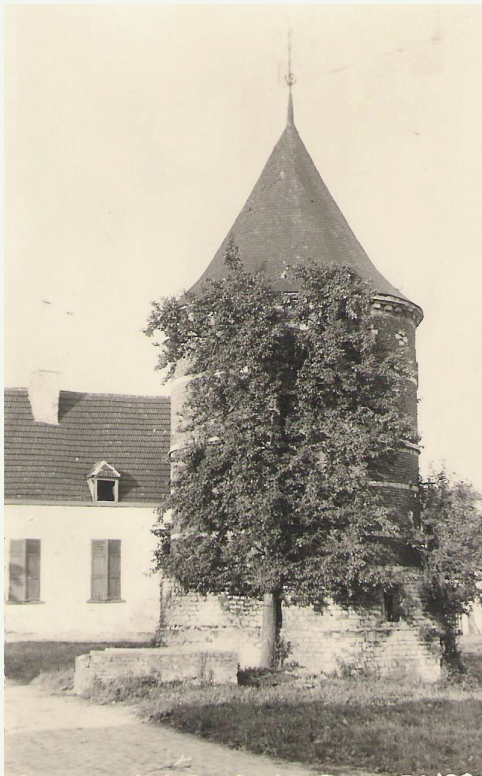
Duiventoren te Eppegem
